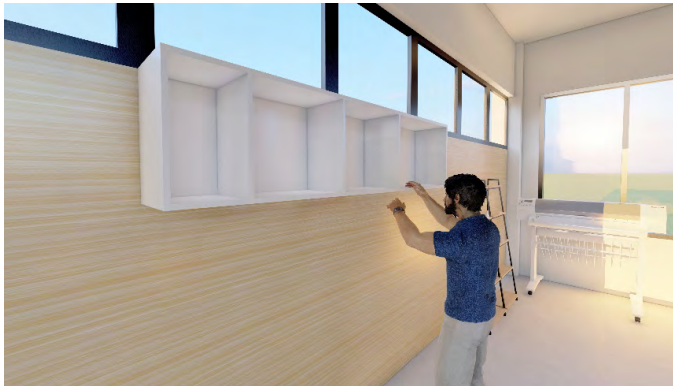
Gambar 4. Ilustrasi pengangkuran lemari
